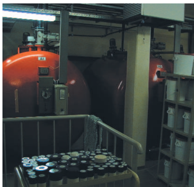
In der Abklinganlage werden radioaktive Abwässer und Abfälle gesammelt.
