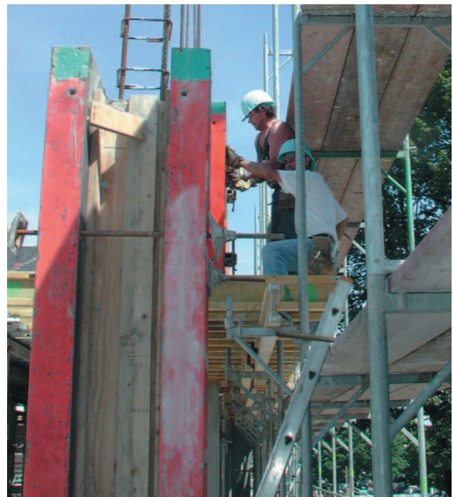
Die Bautätigkeiten des Klinikums Bremen-Mitte werden von Fremdfirmen durchgeführt.
