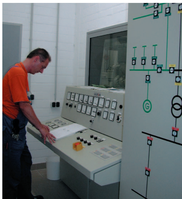
Leitstand Notstromaggregat – ein wesentliches Element der Energieversorgung.
