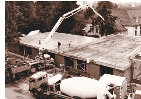
Bau des neuen Zentrumsgebäudes
