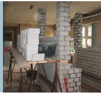
Das neue Gebäude und Umbauarbeiten 2007
